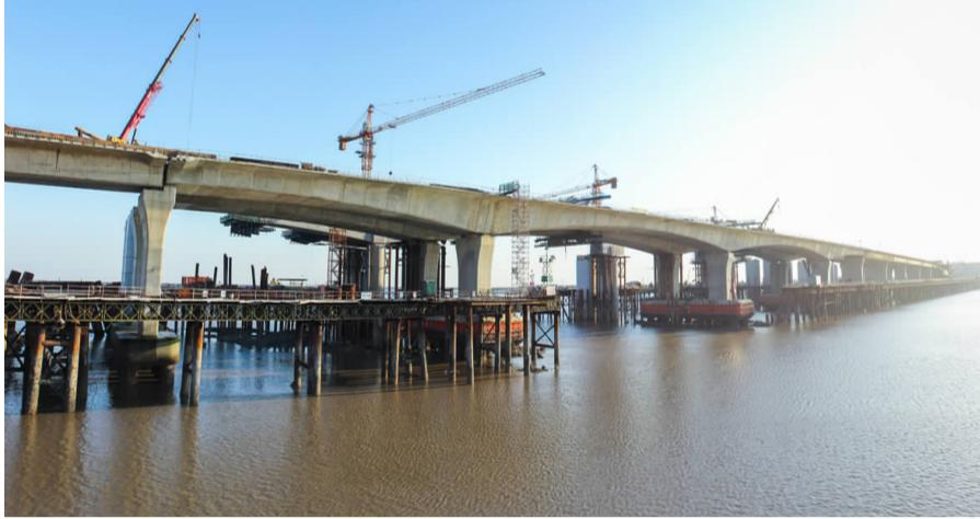
1月19日凌晨4时，随着温州瓯江南口大桥工程主桥右幅两个中跨合龙段的浇筑完成，南口大桥主桥全部合龙。
